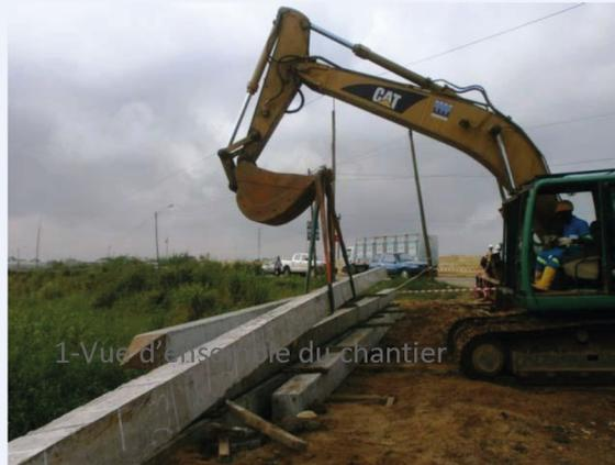
Battage de pieux section 35\*35 cm, essai de chargement
